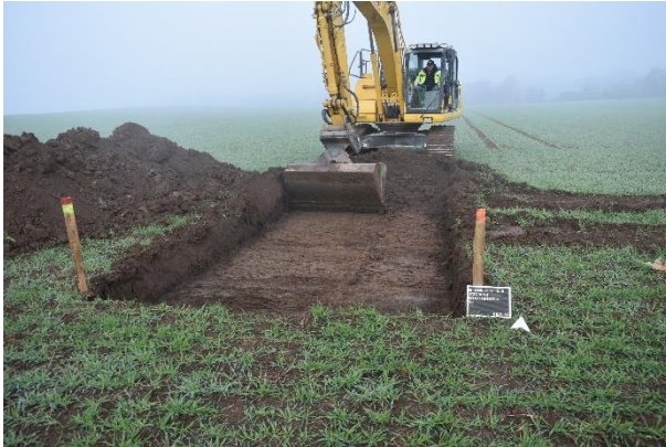
Abb. 4. Oberbodenabtrag im Bereich von Schnitt 6, Situation. Blick von Süden. Aufnahme vom 09.11.2020.
