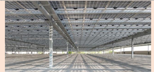
Beispiel Glas/Glas Module: Teillichtdurchfall schafft helle, nutzbare Flächen direkt unter den Modulen. Beispiel zeigt einen Parkplatz, da diese Module bisher auf Grund des höheren Preises eben nicht bei Parks eingesetzt werden. ©Solarwatt
