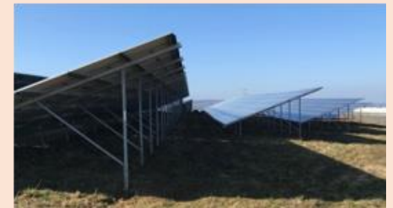
Konventioneller Solarpark Raum Coburg: Kaum Abstand zw. den Reihen und zum Boden, Beschattung der Flächen, geringe Vegetationsqualität, hoher Flächenwirkungsgrad
